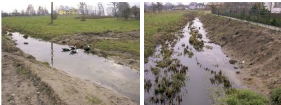
Fot. 7, 8. Przykład antropopresji dotyczącej ciek, będący stanowiskiem łąki ozdobnej – realizacja wiejskiego wodociągu przez ciek (po lewej) i w sąsiedztwie ciek (© W. Michalczyk).
